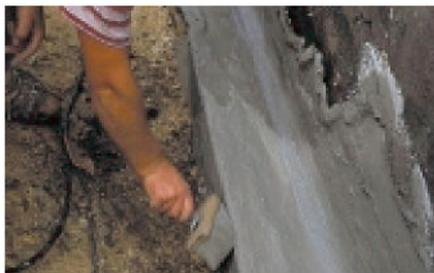
**Dichtungsschlämme** in sogenannten Verkieselungsfolgen aufgetragen. Eine Verkieselungsfolge beinhaltet das Aufsprühen von **Kiesol** und „frisch in frisch“ das Nachschlämmen mit **Dichtungsschlämme**. „Frisch in frisch“ bedeutet nicht „nass in nass“ sondern **Kiesol** muss eingezogen und der Untergrund noch mattflecht sein, dann ist die **Dichtungsschlämme** aufzubringen.
