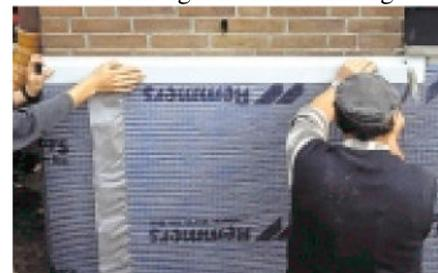
der Abdichtungsschichten ist die Wärmedämmung vollflächig aufzukleben. Bei Konstruktion mit Kellersohlenüberstand sind die Dämmplatten im Dichtungskehlenbereich abzuschragen.
